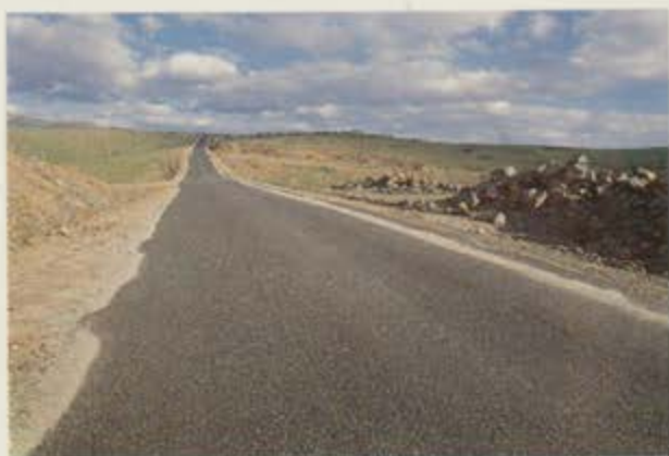
Obras de nuevos accesos a Esparragosa de Lares.
