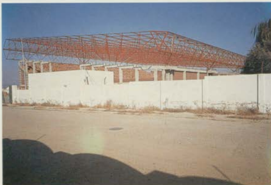
En 1985, dentro de las actividades deportivas, la Comisión de Cultura continuó la realización de las obras previstas en el Plan Quinquenal de Instalaciones Deportivas.
