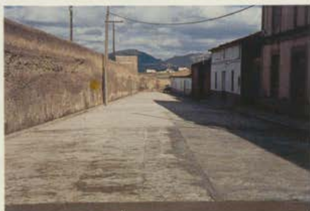
Obras de pavimentación en Cabeza del Buey.
